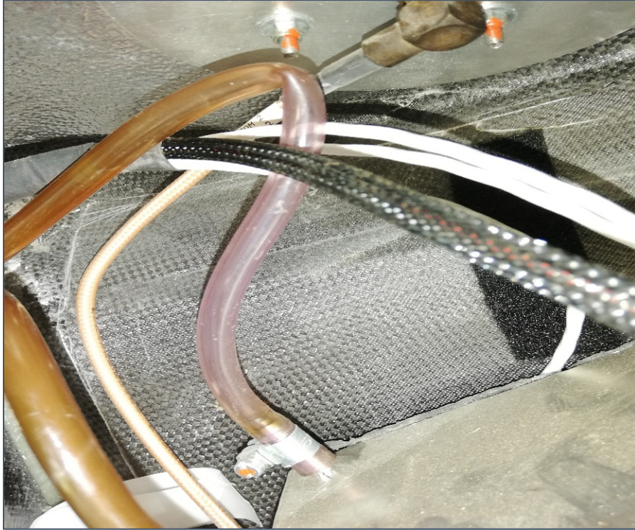
Fotografía No. 6: Línea de ventilación RH HJ439
