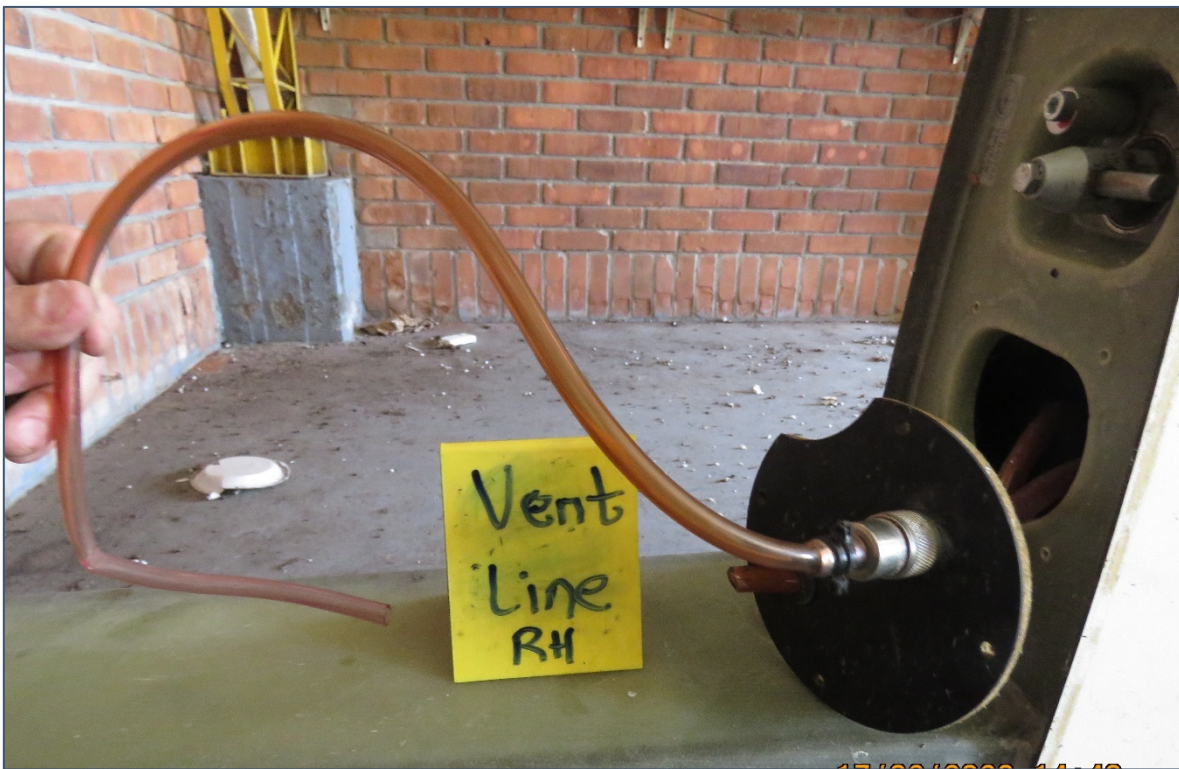
Fotografía No. 7: Línea de ventilación RH HJ439
